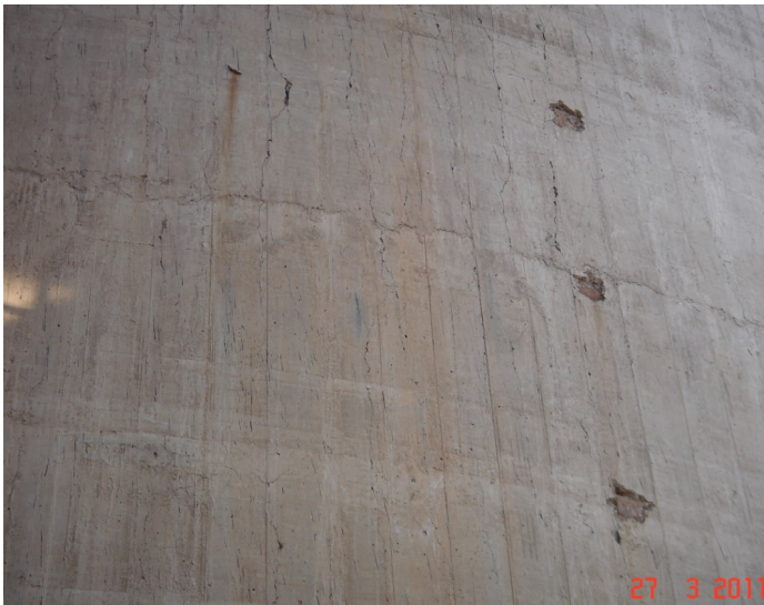
图2 裂缝照片
