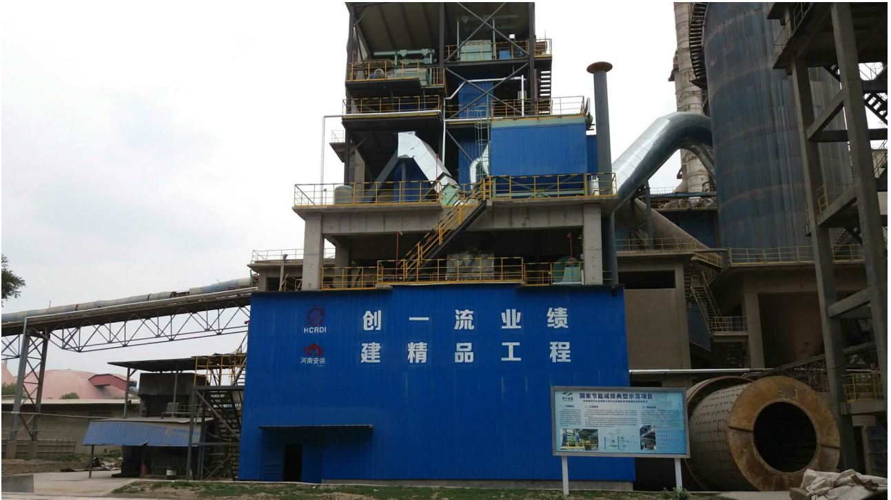
图 4 鹤壁同力 2#原料磨系统改造现场照片
